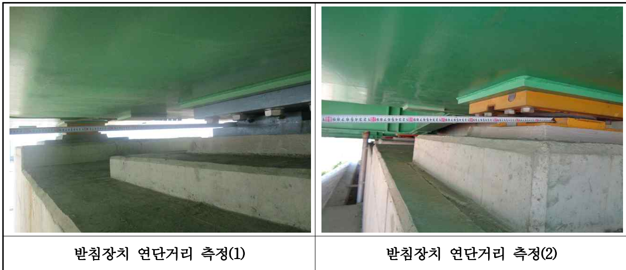
【사진 3.15】교량받침장치 연단거리측정
